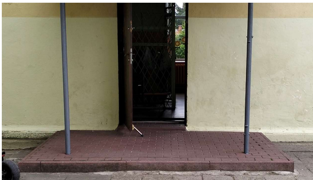
Zdj. nr 6 Widok na drzwi wejściowe z podestem oraz progiem z kostki betonowej oraz słupkami podpierającymi daszek na wejściu
