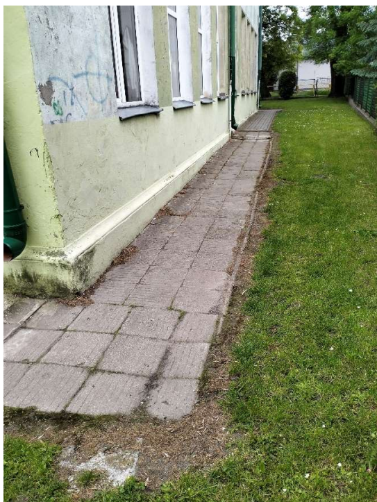
Zdj. nr 4 Widok na opaskę z płyt betonowych od strony zachodniej
