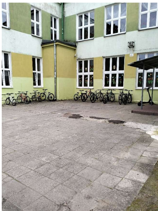
Zdj. nr 2 Widok na istniejące utwardzenie z płyt betonowych
