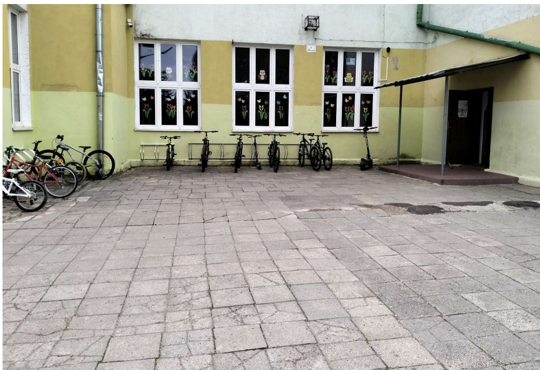
Zdj. nr 1 Widok na istniejące utwardzenie z płyt betonowych
