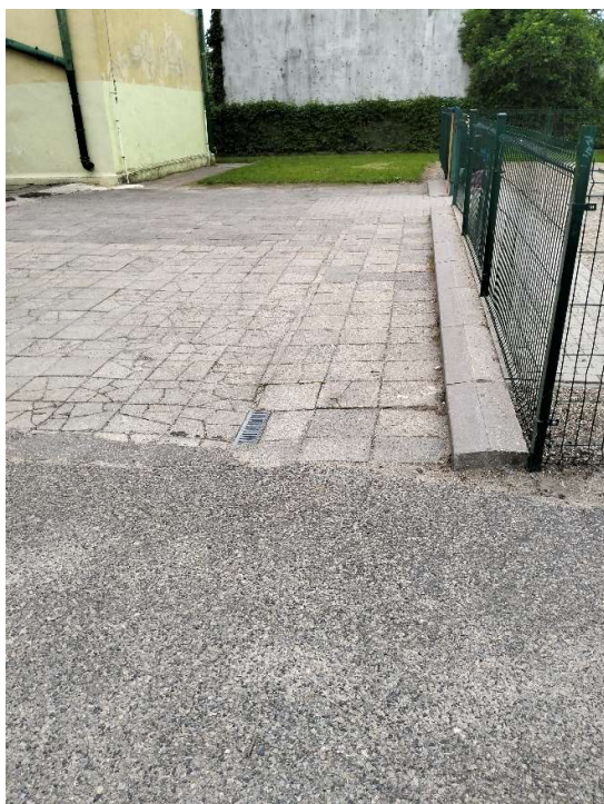
Zdj. nr 7 Widok na utwardzenie z wyprofilowanym lekkim spadkiem przy parku liniowym
